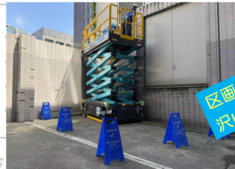
高所作業車区画
