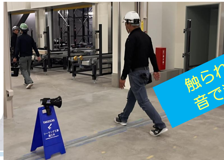
シーリング施工後注意喚起
