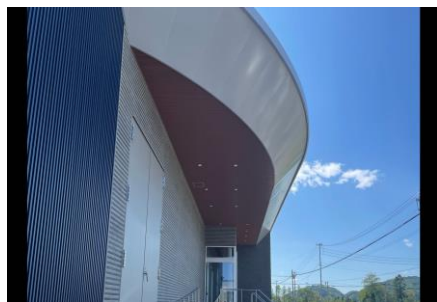
色見本を使用して施工した例（写真-20）
