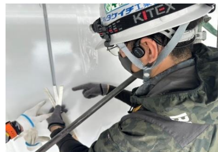
作業中の色確認状況（写真－17）
