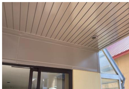
色見本を使用して施工した例（写真-19）
