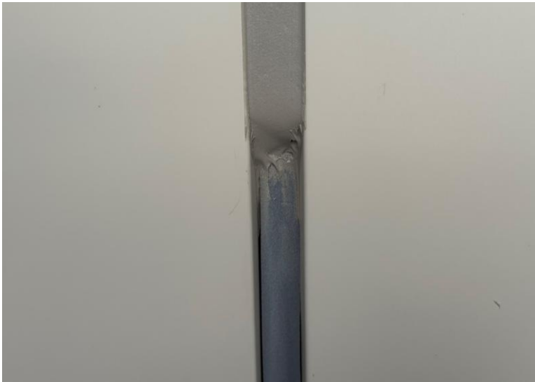
シーリング材充填後
