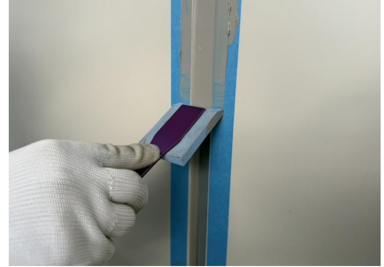
仕上げ状況（金属パネル）
