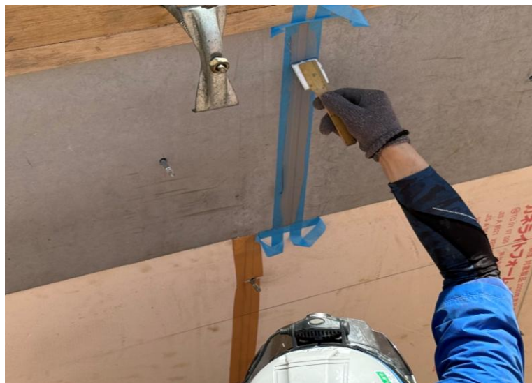
躯体目地仕上げ状況
