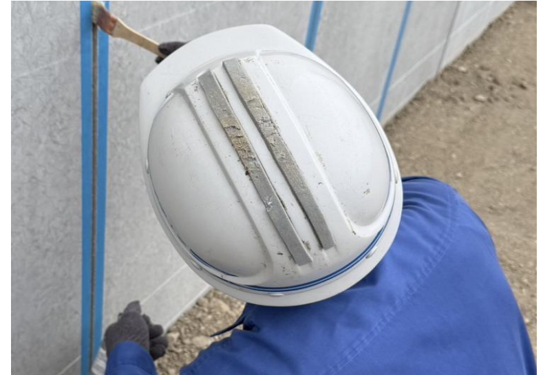
バックアップ材を貼り付け
